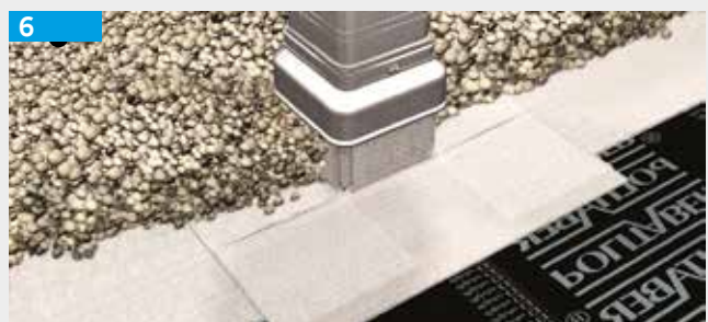
6 Aplicação de um geotêxtil separador e agregado como proteção pesada.
