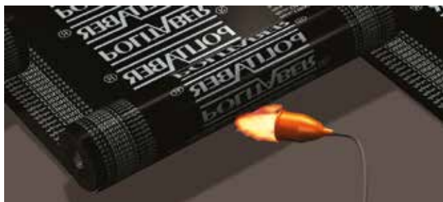
Será soldado à superfície da cobertura e nas sobreposições
