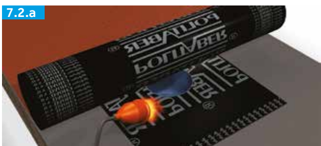
Aplicar a membrana impermeabilizante
