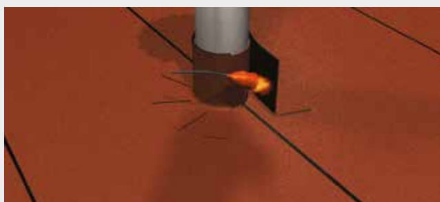
Aplicação de peças de reforço. Sobre o manguito impermeabilização.
