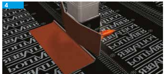
4 Aplicação de peças de reforço. Sobre manga e impermeabilização
