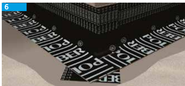
Aplicação das faixas de reforço
