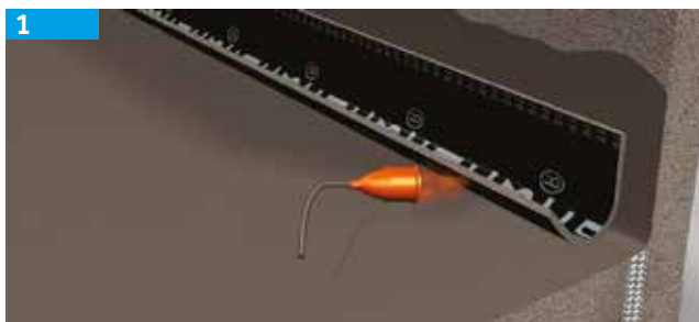
Revestimento com faixas de reforço
