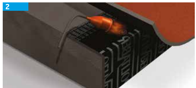
Aplicação da banda de aderência
