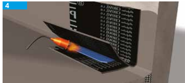
Soldar a peça de reforço (superior)
