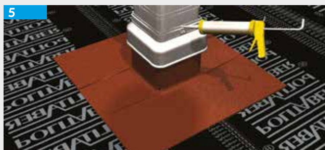
5 Aplicação de uma aba de proteção. Vedação da mesma com mastique.
