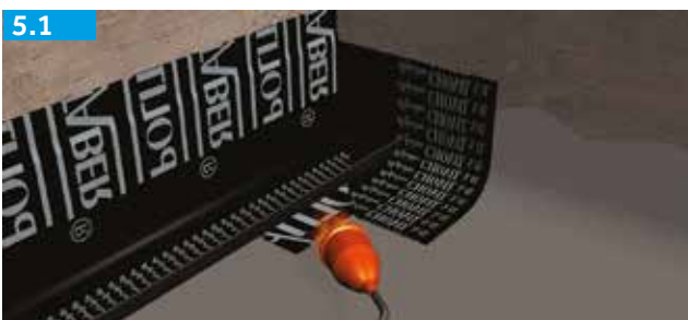
5.1 Aplicação das bandas de reforço
