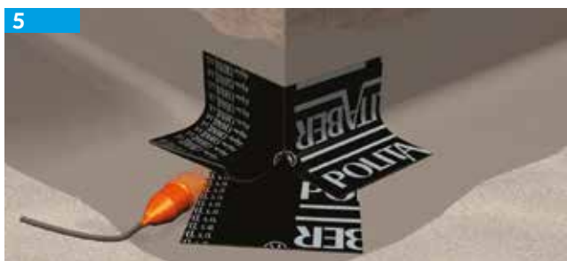
Aplicação da peça de reforço superior. Totalmente aderida
