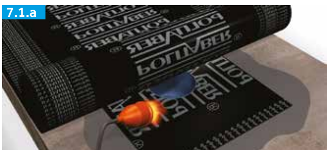
Aplicar a membrana impermeabilizante.
