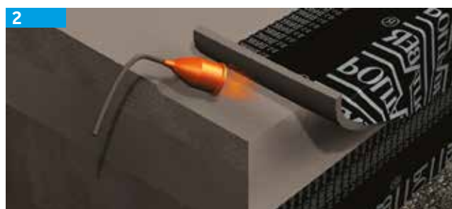
Aplicação da faixa de reforço.
