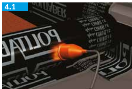
4.1 Aplicação de peças de acabamento: Membrana bicamada
