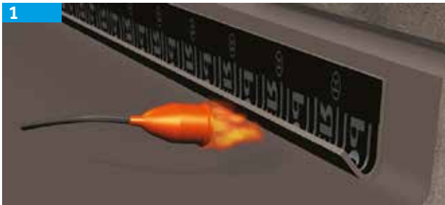
Roço imprimado. Aplicar faixa de reforço.
