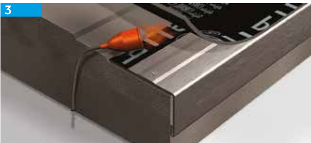
Fixação do perfil.
