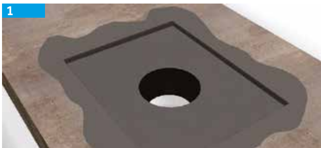
1 Rebaixar a zona dos reforços e aplicar o primário no suporte.
