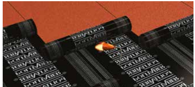
Segunda camada de folhas soldada à anterior
