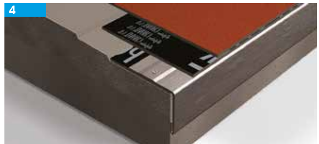
Aplicação da banda de reforço (superior)
