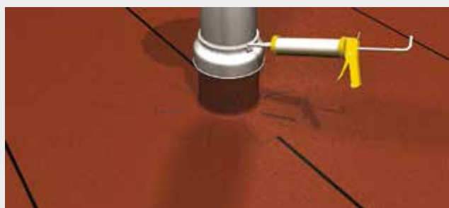
Aplicação de uma aba de proteção. Vedação do mesmo e com massa.
