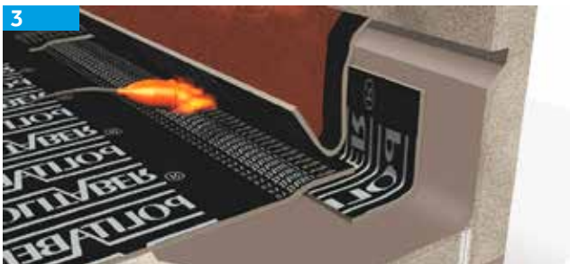
Aplicação da faixa de reforço
