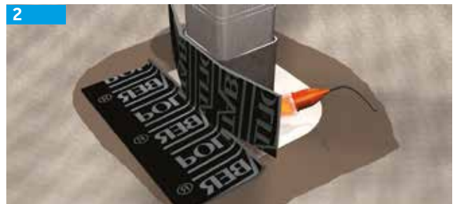
2 Aplicação da peça de reforço inferior.
