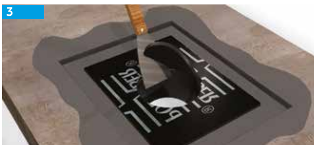
Recortar a peça de reforço inferior.
