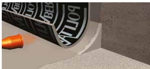
Aplicação da banda de reforço
