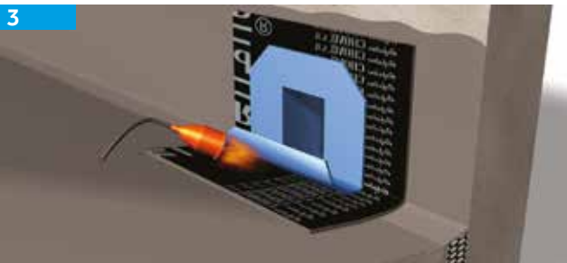
Aplicar a saída de água lateral
