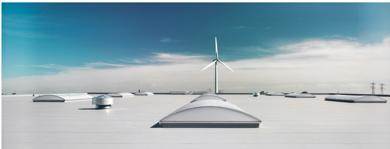
Cobertura não transitável fixada mecanicamente
