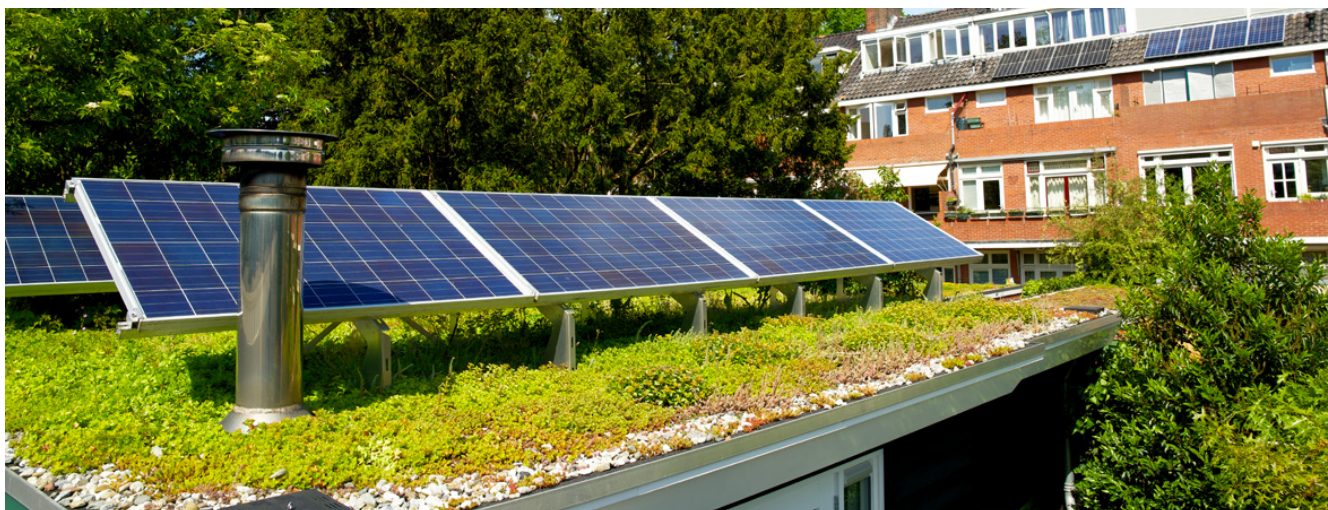
Cobertura solar bioclimática com proteção pesada
